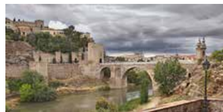
Figura 11. Puente Alcántara. Toledo
