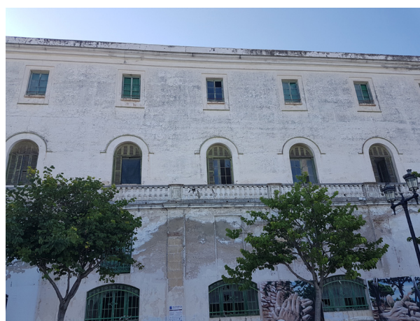
Figura 10. Hospital San Juan de Dios Fachada al río Guadalete
